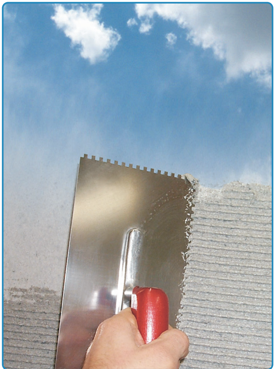
Durch das Auftragen von Meno® mit der Zahntraufel ist die Schichtstärke genau definiert.
